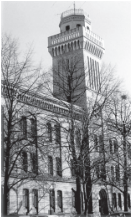
Hauptgebäude am Friedemann-Bach-Platz 6 Foto: Voigt
